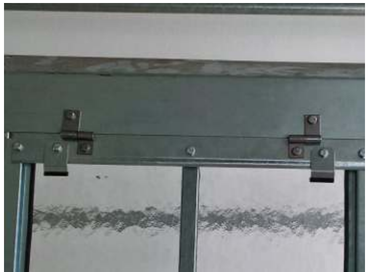
Konstrukce okna je podvlečena pod hřebenový plech (u přístaveb D a E horní střešní plech poz.32.)
