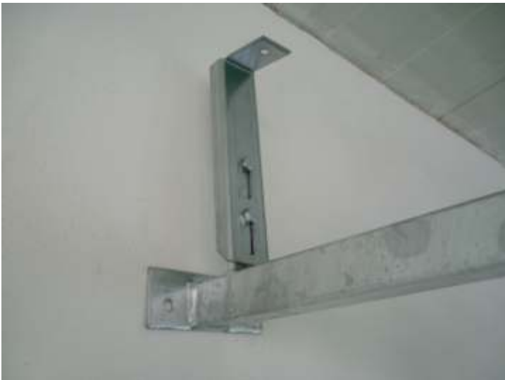
Montáž výztuhy hřebene (poz. 33) k jácklové výztuže.
