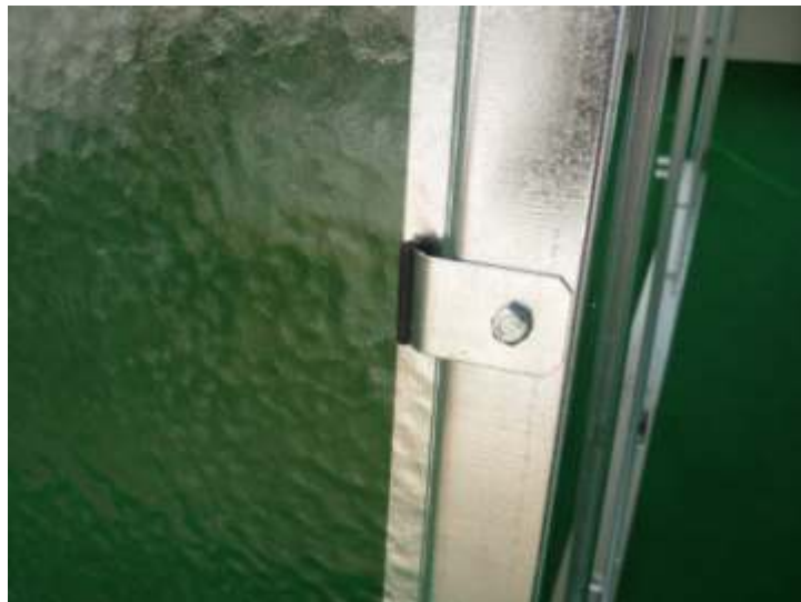
Přichycení bočního skla příchýtkou poz. 83-1
