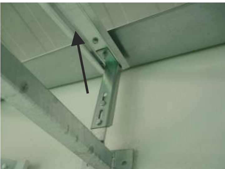
Abychom nemuseli spoj následně rozebírat přimontujeme ke hřebenovému plechu (D 18) sloupek s pěti otvory (poz. E 31)
